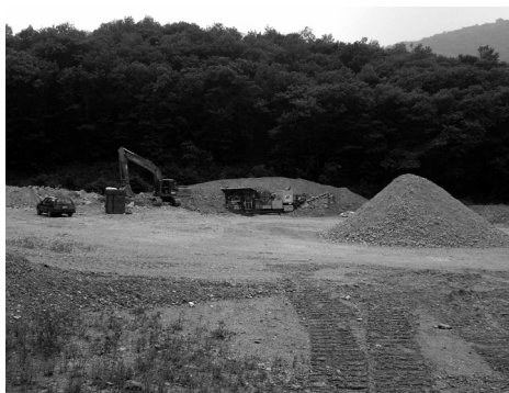
Deposito di Sigirino/TI. Alptransit. Photo: Ch.Girot
