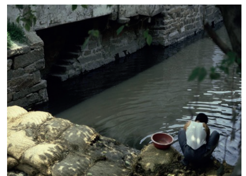
Wasserkanal befestigt mit Sandsäcken in Souzhou, China. Photo: Christophe Girot, 1981
